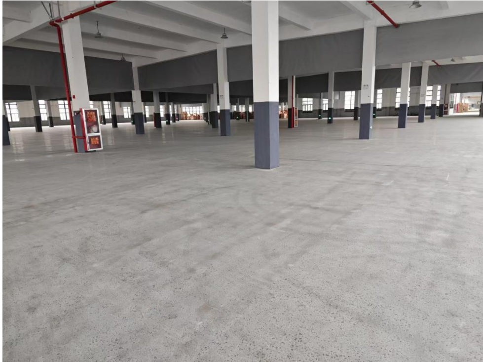
现有空厂房照片
